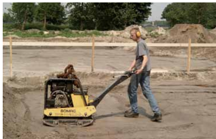
Maak van tevoren een goede inschatting van het werk waarbij wordt getrild en kies een efficiënte werkwijze uit, waardoor je niet onnodig lang hoeft te trillen.
